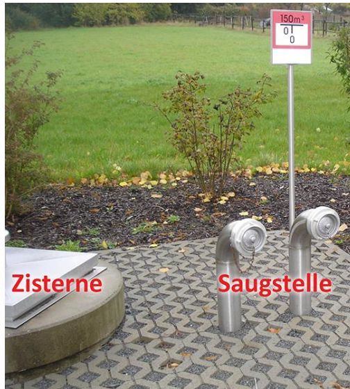
Zisterne (unterirdischer Wasserbehälter)
