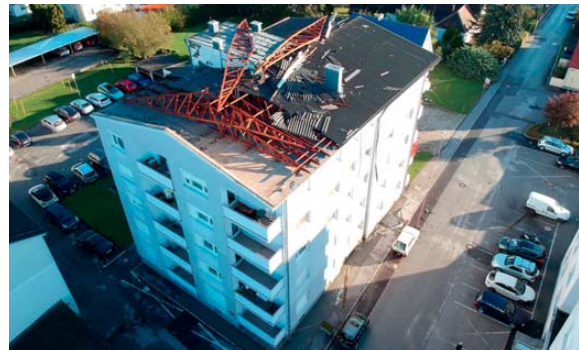
Abgedachtes Haus in Großpetersdorf
