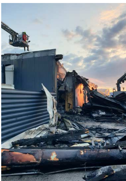
Am Morgen nach dem Brand wurde die ganze Zerstörung sichtbar.
