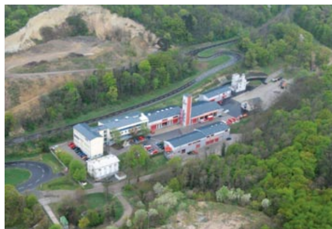
Luftaufnahme nach umfassenden Umbauarbeiten im Jahr 2011.
