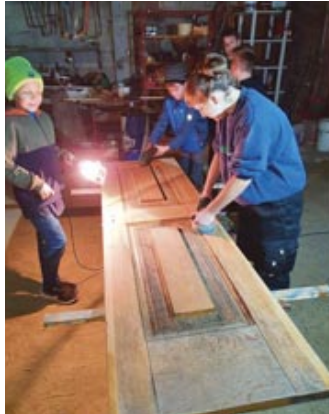
Die Eingangstür der Floriani-Kapelle in Donnerskirchen wurde abgeschliffen und neu gestrichen.
