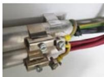
Das metallische Rohrsystem ist an beiden Seiten zu erden.
